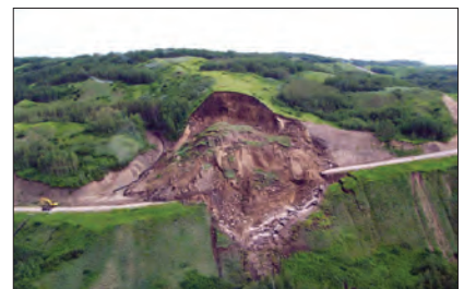
Rupture de talus ou de versants
