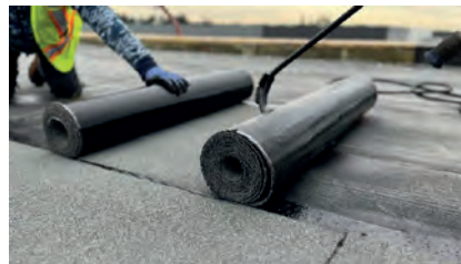
Déroutage et soudure au chalumeau d'une membrane SBS sur une toiture (Fig.1)
