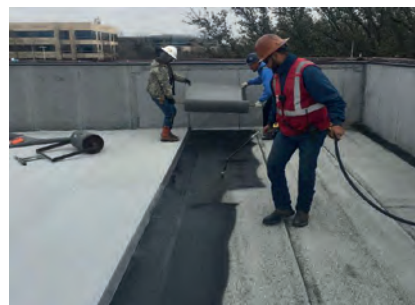
Pose de membrane APP sur une toiture (Fig.3)
